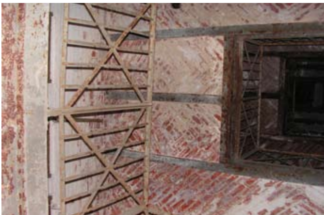
Na górne kondygnacje prowadziły kręte schody. Dziś pozostały tylko balustrady fol. L. Pietrzak
